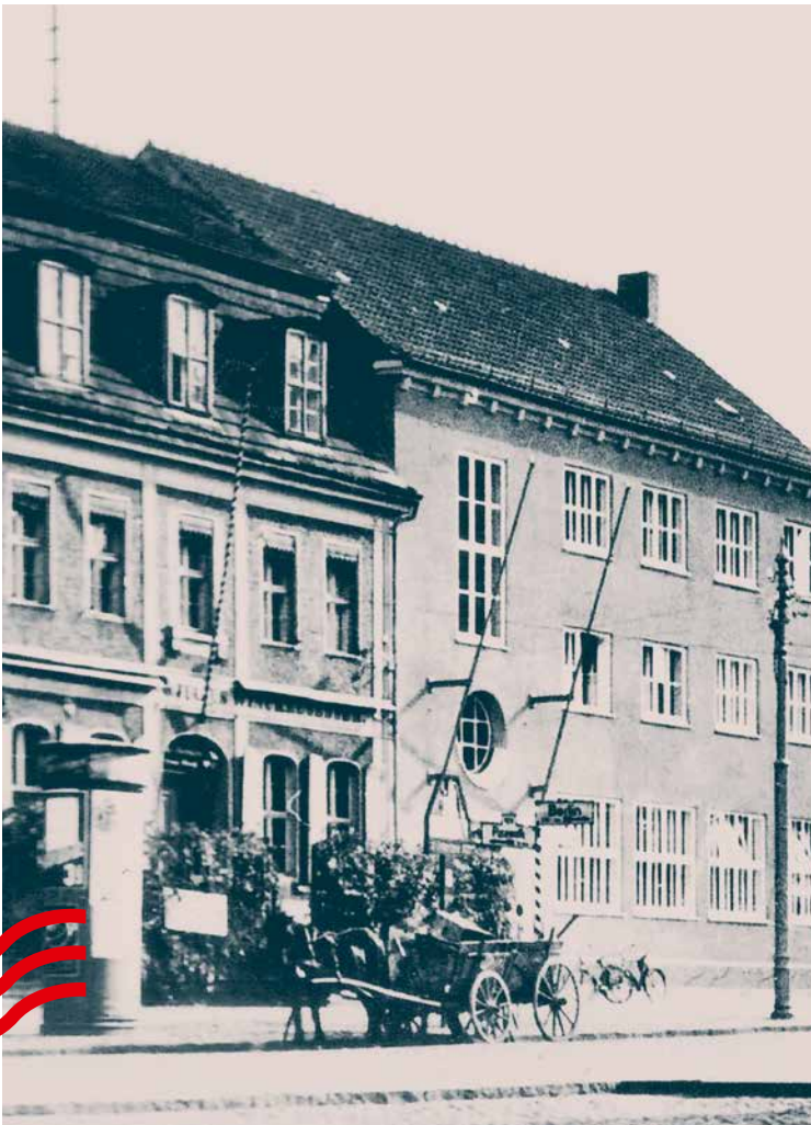
Abb. 39: Das Gebäude der Prenzlauer Stadtsparkasse (mit dem runden Fenster) in der Steinstraße 405 vor 1945
